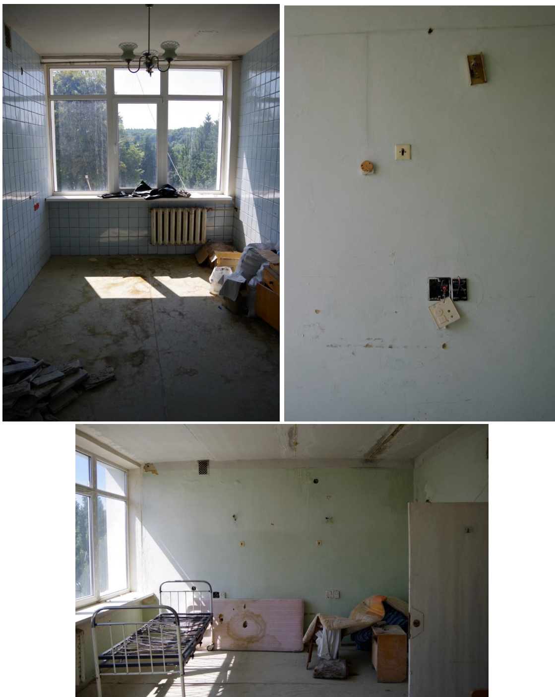
Мал. 7. Поточний стан приміщень 3-го поверху Хірургічного відділення Лікарні. 48
